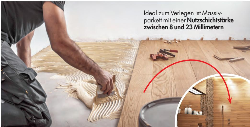
Ideal zum Verlegen ist Massivparkett mit einer **Nutzschichtstärke zwischen 8 und 23 Millimetern**
